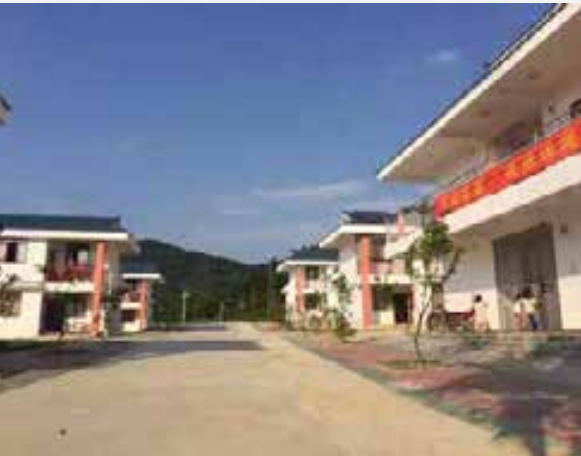
芽铺村的新面貌
